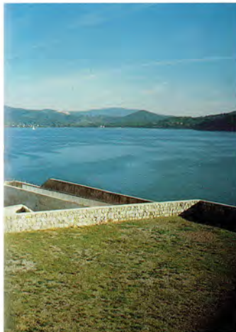
Sotto a destra: veduta delle fortificazioni (particolare).
