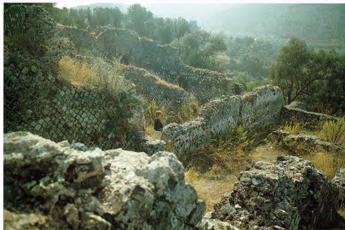
Sopra: veduta dei ruderi della villa di epoca romana delle Grotte (I sec. d.C.)
